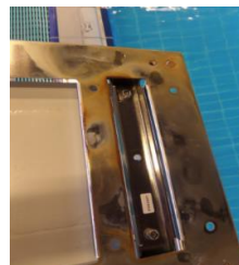
OSB mal entretenu
